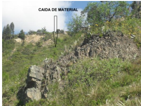
FIGURA. 59 Caída de Roca.
