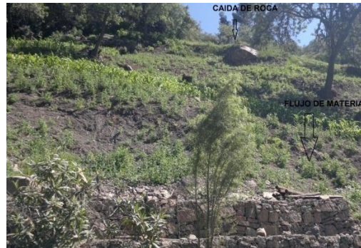
FIGURA. 50 Afectación en la vía.
