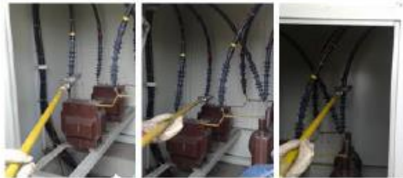
Figura 13. Verificación de corrientes en el transformador de corriente medida indirecta.
