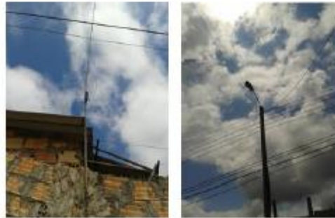
Figura 6. Inspección visual de acometida.
