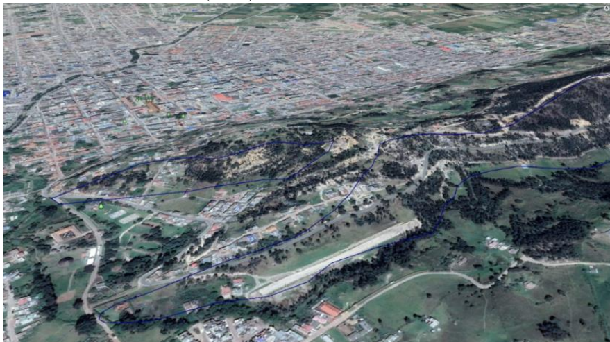
Figura 42. Ladera estructural de sierra sinclinal (Sssle )
