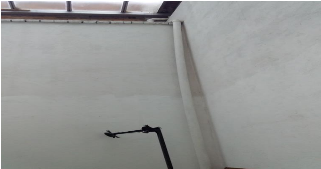
Foto 4. Riesgo de la documentación por posible inundación
