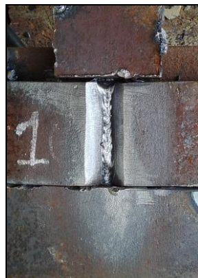
Figura 20. Limpieza entre pases de la soldadura.
