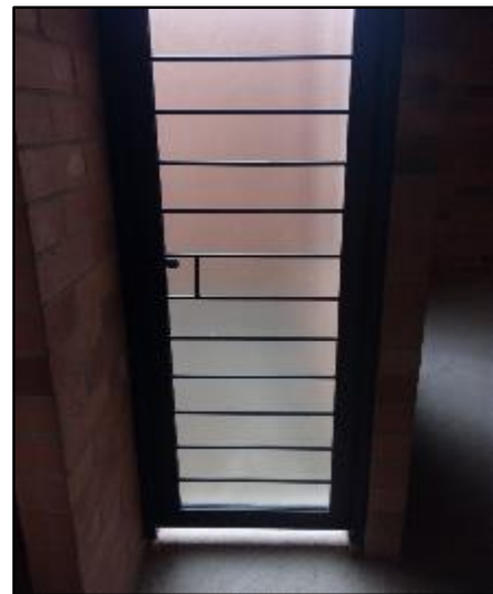
Imagen 30. Instalación de puertas
