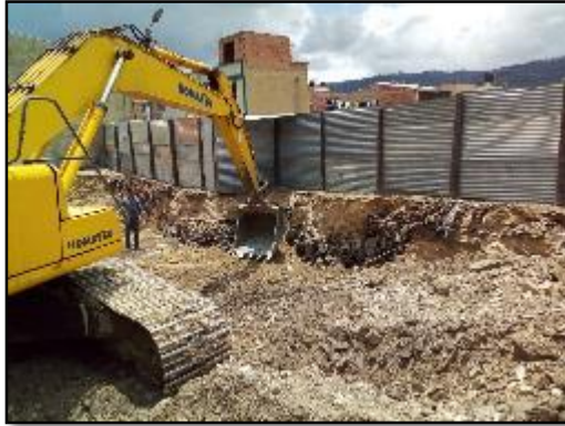
Imagen 3. Excavación manzana 3A
