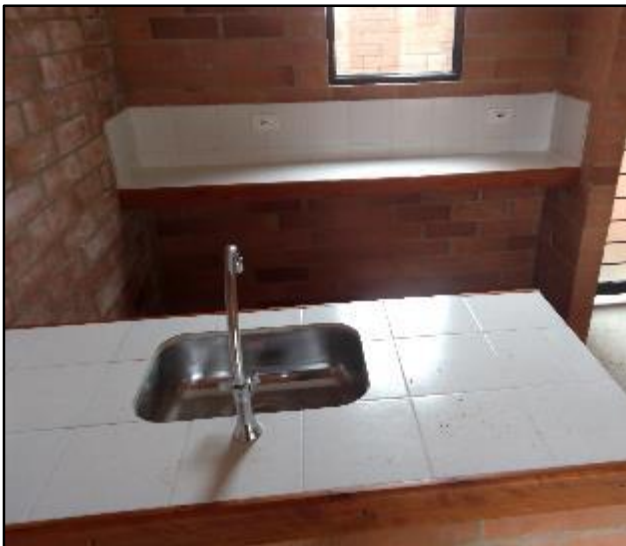
Imagen 29. Mesón de lavaplatos terminado
