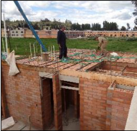
Imagen 23. Construcción de placa
