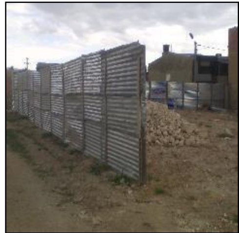
Imagen 2. Cerramiento vista externa
