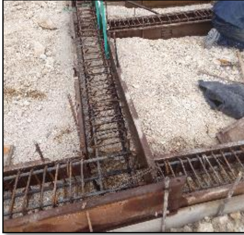
Imagen 15. Colocación de formaleta
