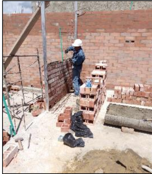
Imagen 20. Construcci3n de muros
