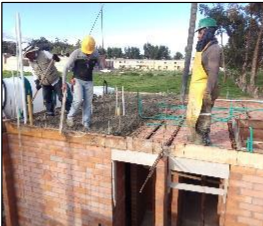
Imagen 25. Vaciado del concreto
