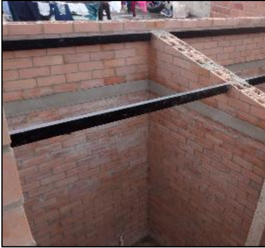
Imagen 27. Instalación de perfiles
