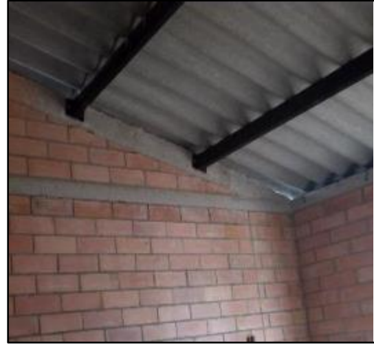
Imagen 28. Instalación de teja
