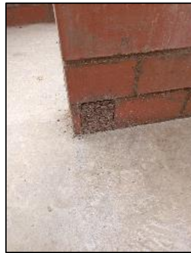
Imagen 22. Dovelada fundida
