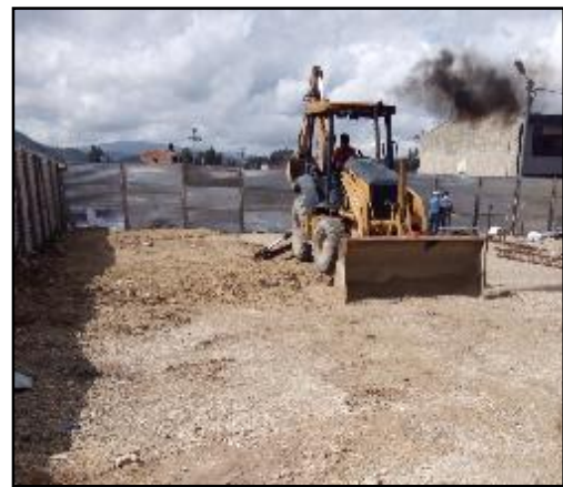
Imagen 6. Extendido de material
