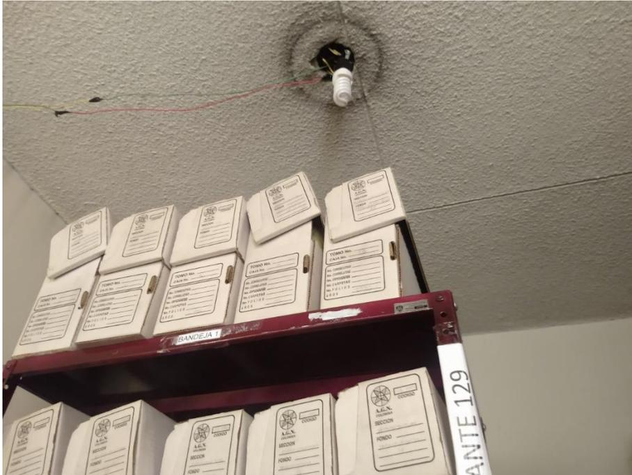
Estado del cableado eléctrico dentro del archivo, visible, sin seguridad frente a alguna chispa producto de cortos circuitos y cerca de la documentación.
