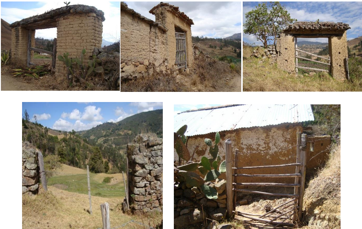
Figura 37. Portales en adobe, tapia pisada, piedra y madera al ingreso de algunas fincas. Fuente: Moreno, L. (2015)
