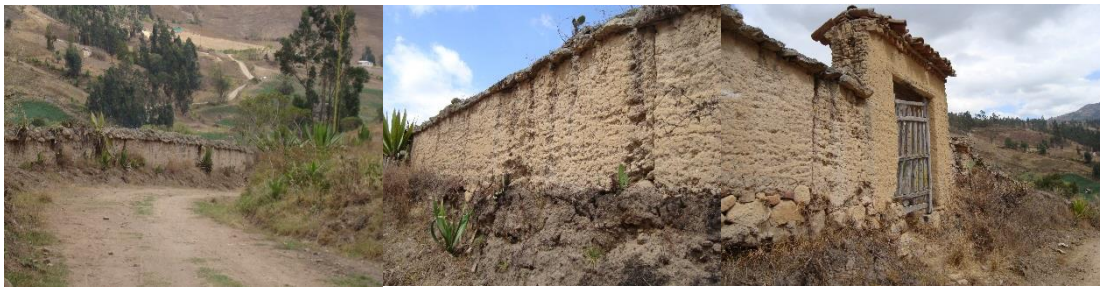
Figura 14: Fotografía muro en tapia pisada, vereda Centro, municipio de Turmequé. Fuente: Moreno, L. 2015
