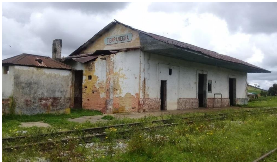
Figura 45. Estación del ferrocarril de Tierra Negra, ubicada en la vereda Puente de Boyacá. Declarada BIC de la Nación, Decreto 746 del 24 de abril de 1996. Fuente: Moreno, L. (2014)
