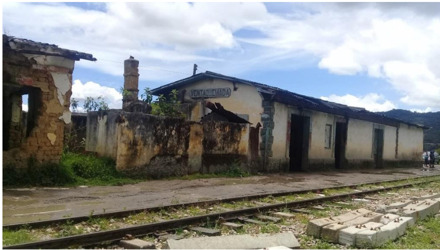
Figura 44. Estación del ferrocarril de Ventaquemada, ubicada en la vereda Parroquia Vieja. Declarada BIC de la Nación, Decreto 746 del 24 de abril de 1996. Fuente: Moreno, L. (2017)
