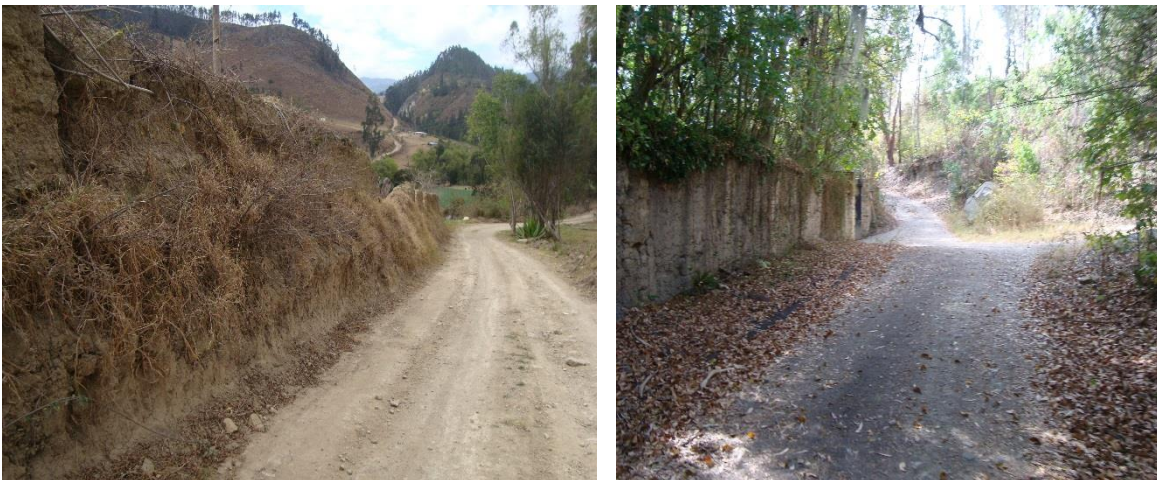
Figura 34: Fotografía muestra muros en tapia pisada a un lado del camino Fuente: Moreno, L. (2015)
