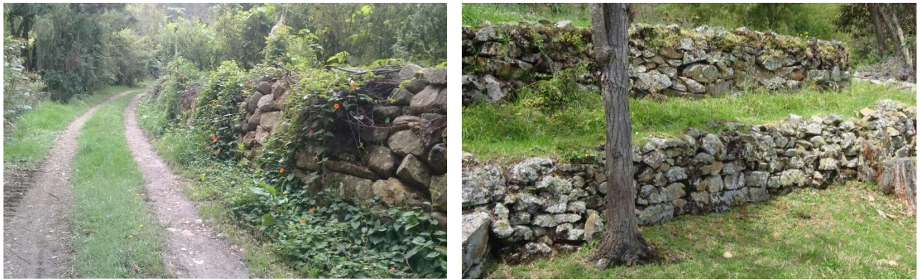
Figura 35 y 36: Fotografía de la izquierda muro lateral en piedra a un lado del camino en el valle, fotografía de la derecha muro de contención en piedra al lado y lado del camino en la pendiente. Fuente: Moreno, L. (2015)
