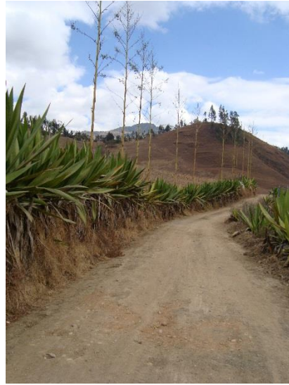
Figura 33: Tramo del Caminos donde se evidencia la calzada con recebo. Fuente: Moreno, L. (2016)
