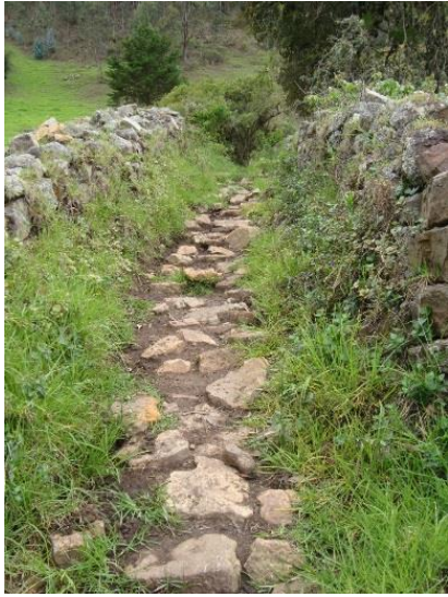
Figura 32: Tramo del Caminos donde se evidencia la calzada en piedra. Fuente: Moreno, L. (2016)
