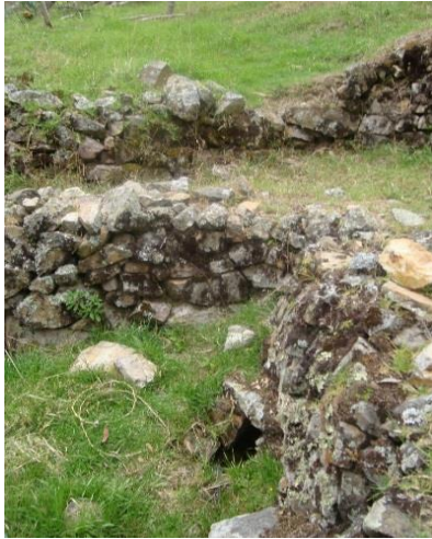
Figura 38: Fotografía muestra el desagüe, alcantarilla o drenaje y muros en piedra al lado y lado del camino.
