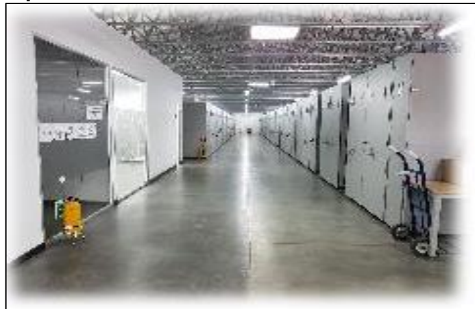
Figura 26. Vista general de la estructura del del Depósito de Archivos en la Sede Operativa
