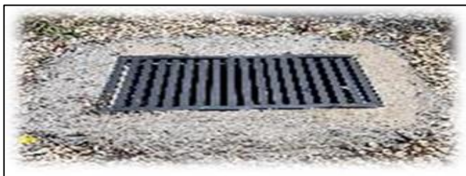
Figura 21. Desagüe cercano al depósito de archivo.
