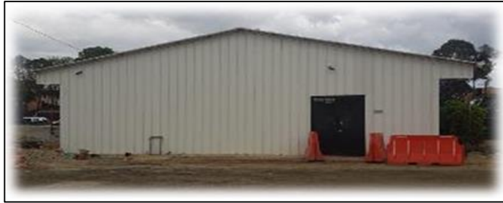
Figura 25. Frente del Depósito de Archivos en la Sede Operativa
