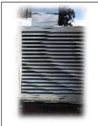
Figura 33. Equipo de aire asistido inyector y extractor.
