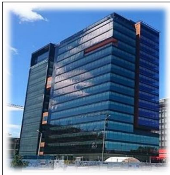
Figura 4. Edificio actual de la sede administrativa
