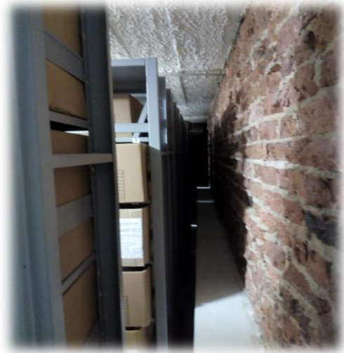
Fotografía No. 4. Detalle del interior del depósito: muros en ladrillo a la vista; techo en hormigón – revestimiento-permeabilidad en cal; paredes externas pañetadas y pintadas; pisos en cerámica de tráfico pesado.
