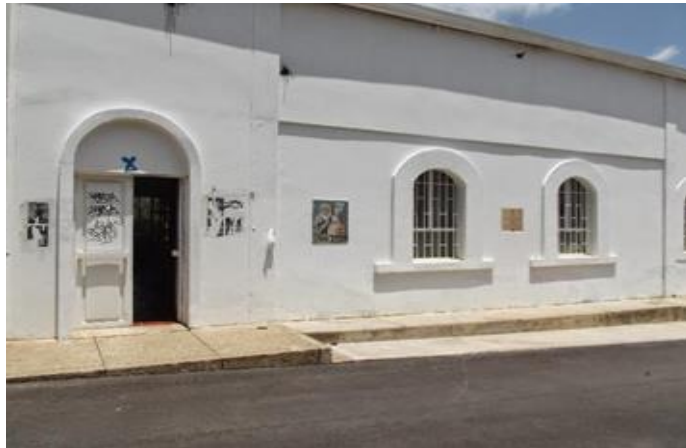
Foto 1. Entrada edificio Archivo Histórico
