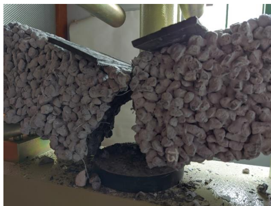
Ilustración 16. Falla de viga, por ensayo de resistencia a flexión. Fuente: Autor.
