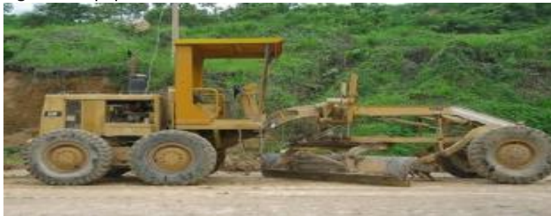
Figura 9. Equipos de nivelación CAT 120G
