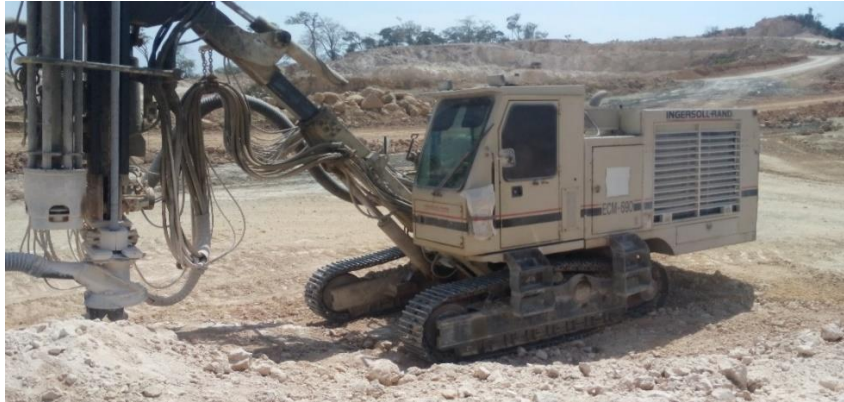
Figura 8. Equipos de perforación ECM 690
