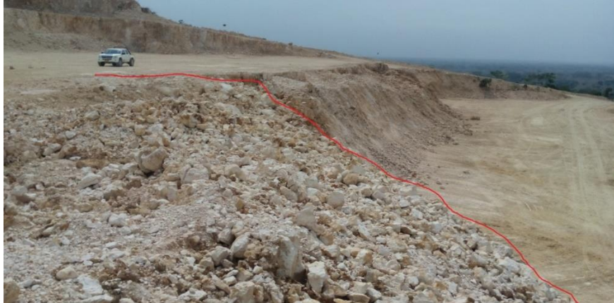
Figura 20. Fragmentación de la roca post voladura
