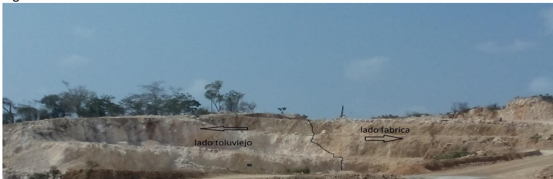
Figura 24. Frente 1 cerro villa nueva
