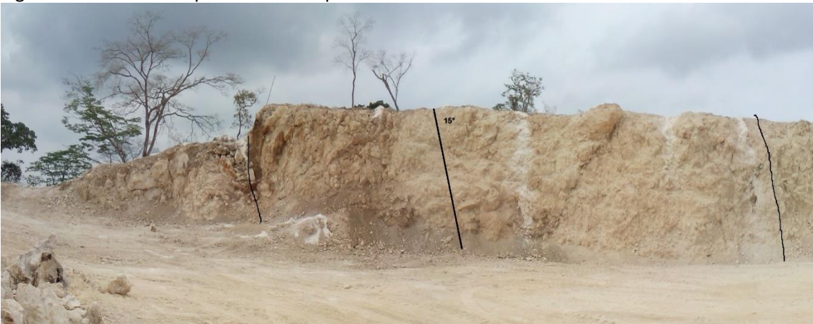
Figura 11. Dirección de perforación del perforador MC690
