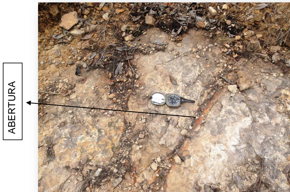
FOTO 12. Abertura de las fisuras
