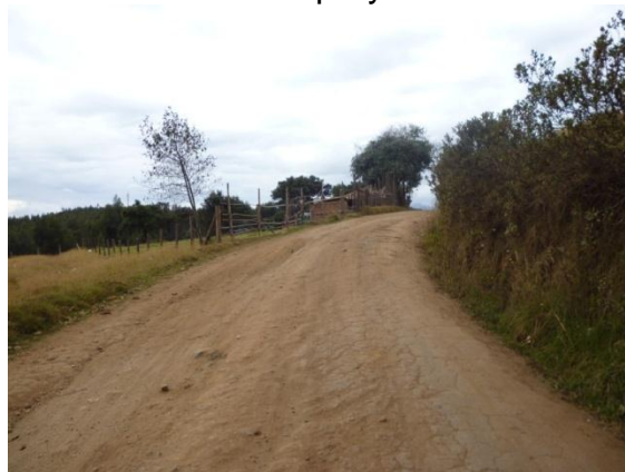
Foto 2. Vía de acceso al proyecto en buen estado.
