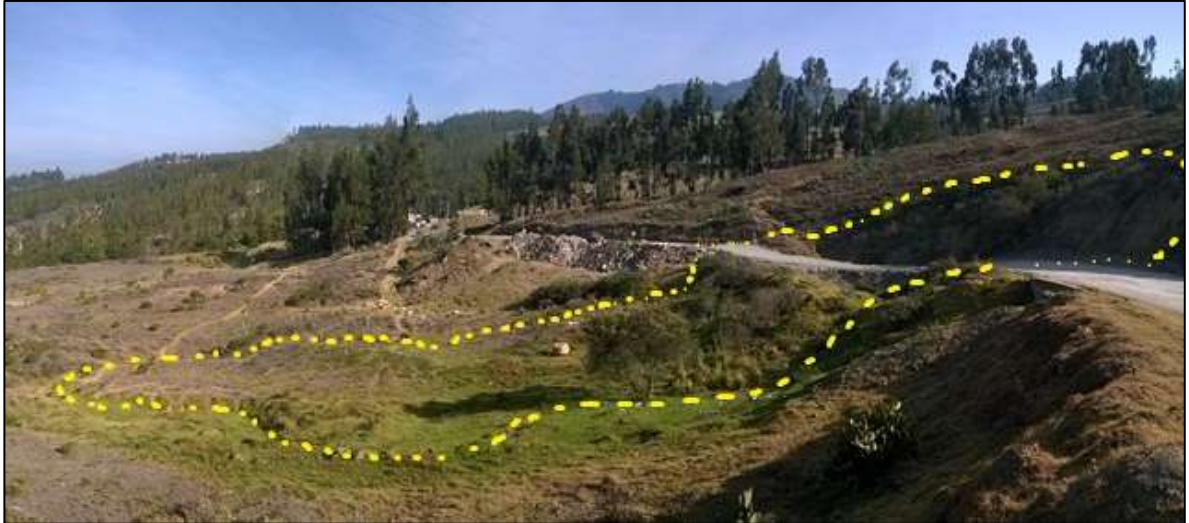
Fotografía 3 Ubicación y Delimitación del Fenómeno de la remoción en masa, ubicado en el K4+180 Vía Gámeza
