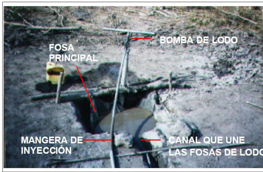
Figura 25. Sistema de inyección de lodo en el pozo.
