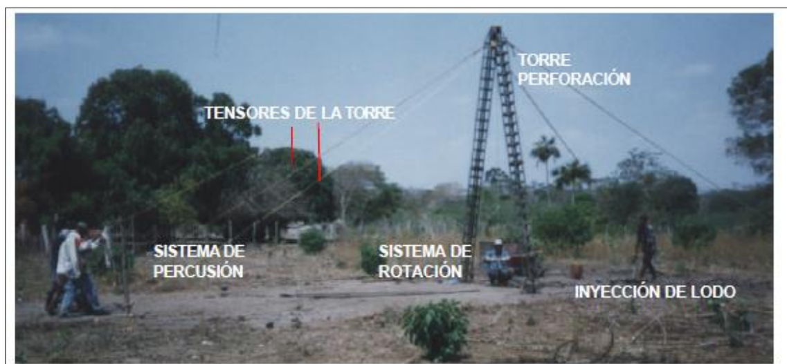
Figura 24. Tensores de la torre de perforación.
