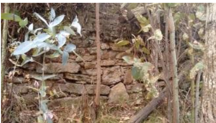
Ilustración 40. Muros del molino (tomada en 2016).
