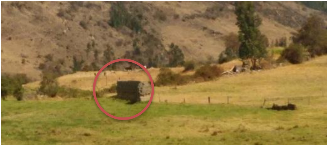
Ilustración 1. De acuerdo con los sabedores, estas ruinas de muros de adobe corresponden a los vestigios de las paredes laterales del convento de los franciscanos establecidos en Tota. Vereda Toquechá (tomada en 2016).
