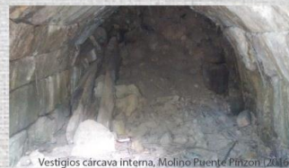
Vestigios cárcava interna, Molino Puente Pinzón (2016)
