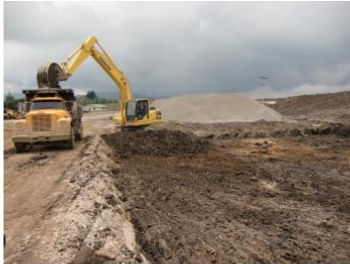
Imagen 7. Excavadora Komatsu pc 200-2.
