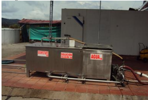
Figura 12. PTAR Picos del Sicuara, 2018
