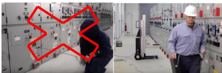
Figura 34. Equipo extraer remotamente interruptores.
