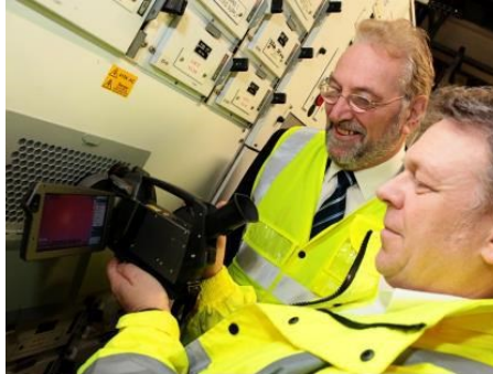
Figura 35. Termografía a través de ventanas infrarrojas.
