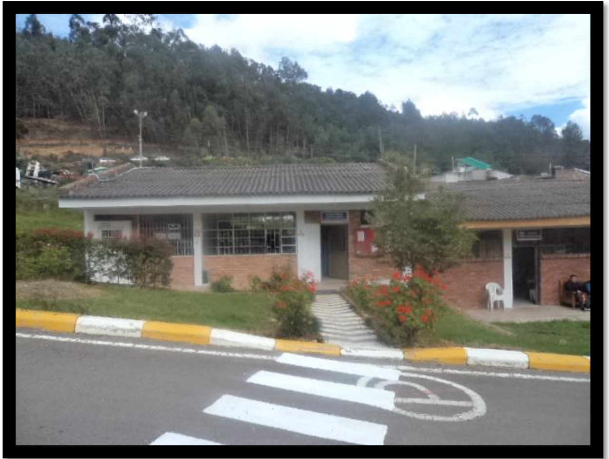
Oficinas de la unidad operacional del instituto y auditorio. Fuente elaboración propia.
