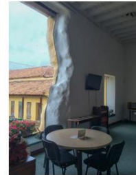
Cerramientos de vanos con vidrio templados
