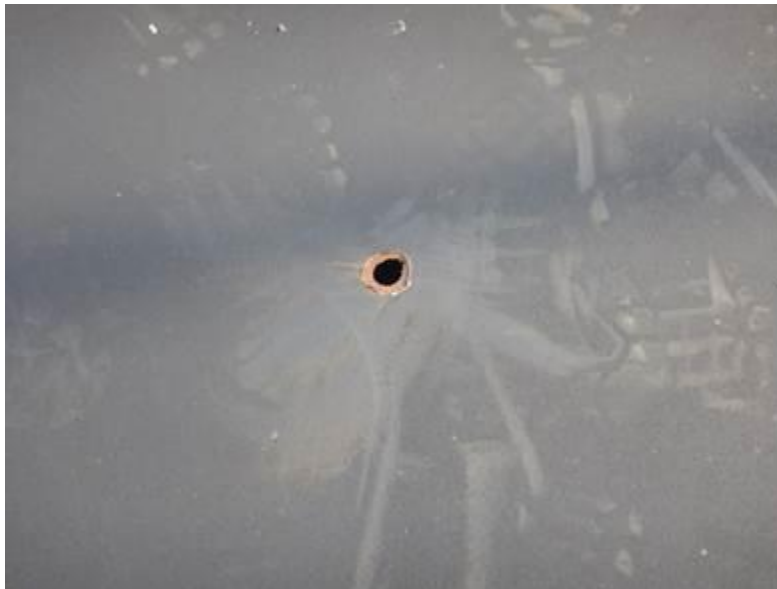
Foto 8. Corrosión pasante en el centro de la lámina, en la zona de vapores.
