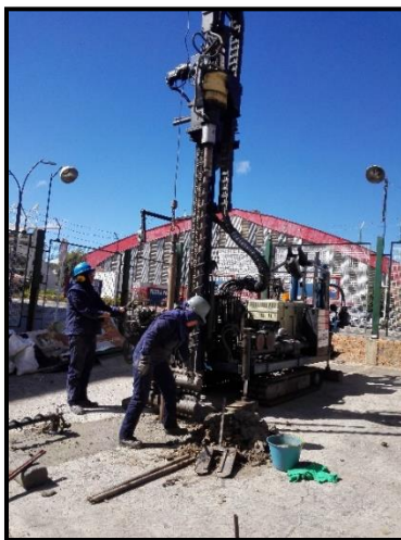
Figura 34. Perforación mecánica frente al Coliseo – Sitio 4
