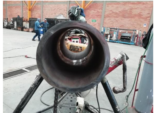
Fotografía 8: Inspección diseño de junta
