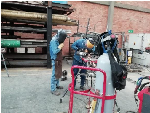
Fotografía 9: Aplicación procesos de soldadura
