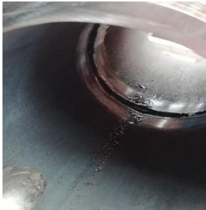
Fotografía 15: Verificación penetración de soldadura en probeta número 1
