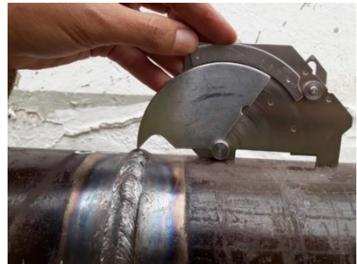
Fotografía 22: Exceso de sobre espesor (soldadura a tope) y socavado en la probeta número 1
