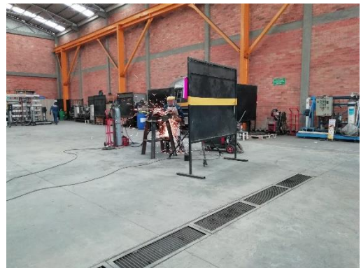
Fotografía 10: Adecuación zona de trabajo
