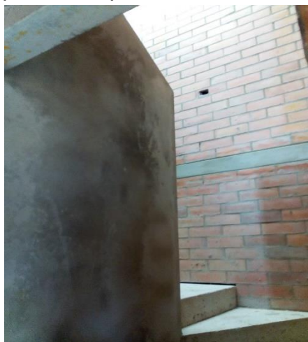
Ilustración 59. Muro pañetado que sostiene la escalera de las viviendas.
