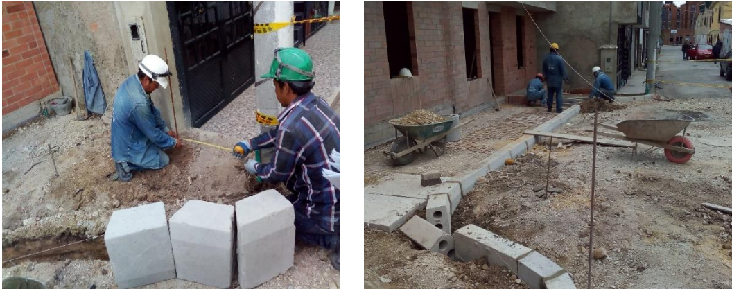
Ilustración 74. Instalación de sardineles para los andenes del proyecto.
