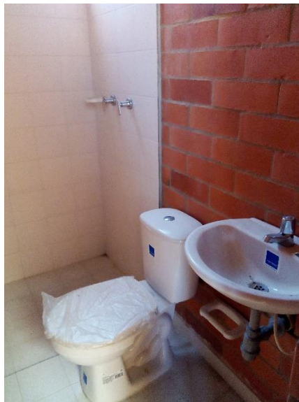
Ilustración 66. Instalación de aparatos sanitarios en el baño de la segunda planta de las viviendas.
