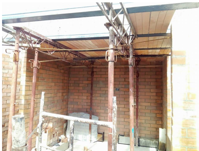
Ilustración 48. Instalación de perfiles colmena y bloquelón para placa de entrepiso.
