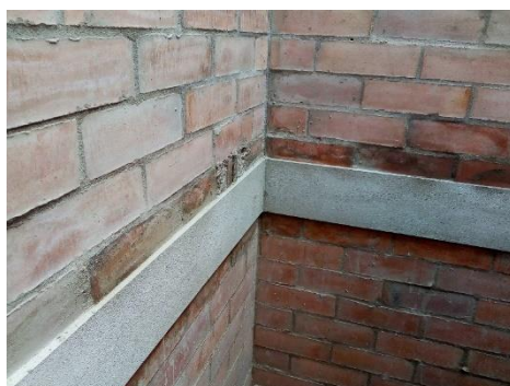
Ilustración 61. Pañetes y acabados sobre vigas de las viviendas.
