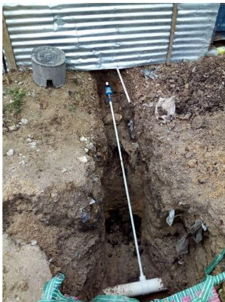
Ilustración 25. Acometida de agua potable y acometida para la energía eléctrica.
