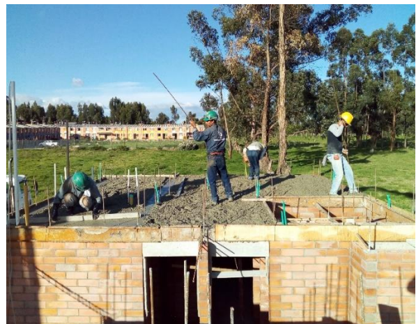
Ilustración 51. Vaciado del concreto placa de entrepiso de las viviendas de la manzana 3A.
