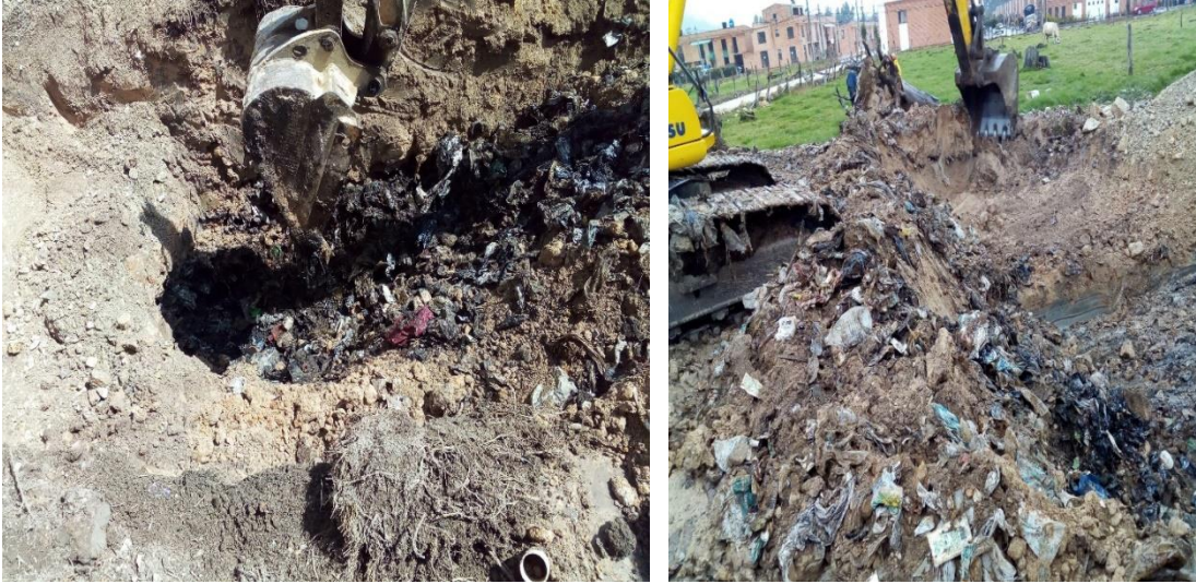
Ilustración 15. Excavación en predio de la manzana 5.
