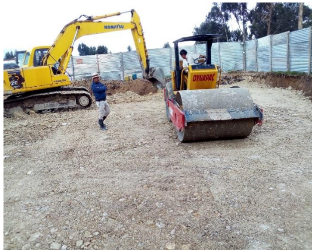
Ilustración 19. Extendido y compactación de material de recebo B-200.
