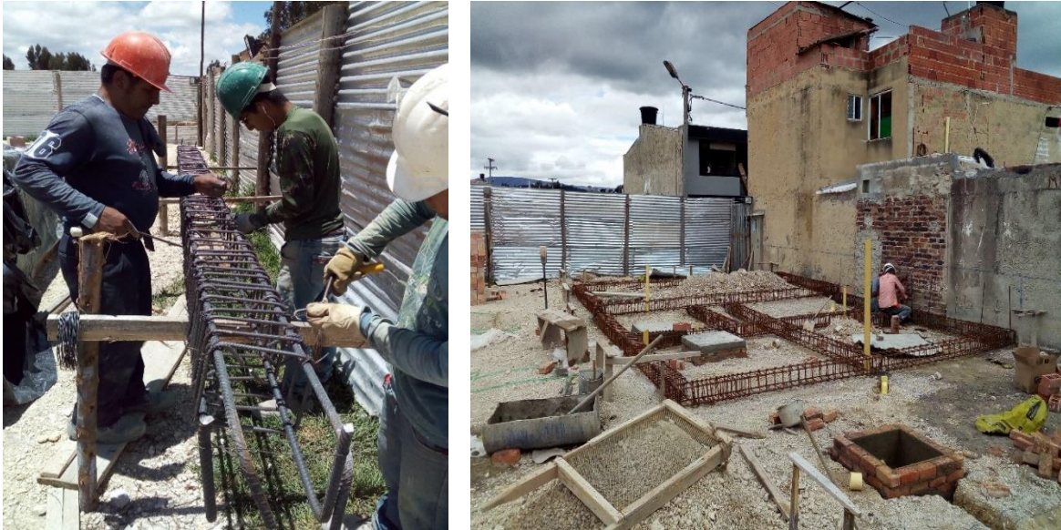
Ilustración 29. Amarre y colocación de refuerzos para las viviendas de la manzana 3a del proyecto.
