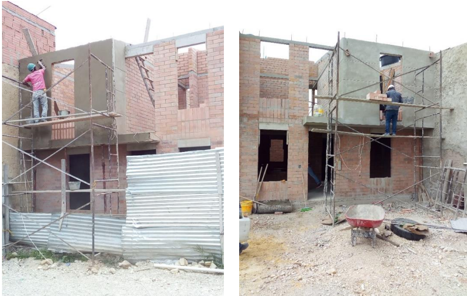
Ilustración 62. Fachada de las viviendas pañetadas.
