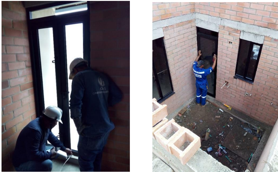
Ilustración 67. Instalación de carpintería metálica y vidrios.
