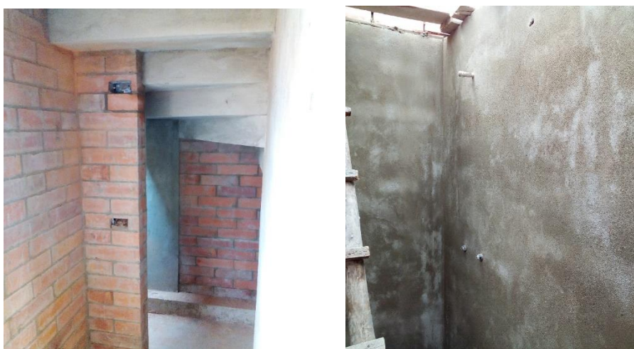
Ilustración 61. Pañetes y acabados sobre vigas de las viviendas.
