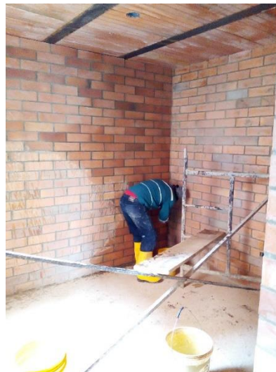
Ilustración 63. Lavado del ladrillo de las viviendas.
