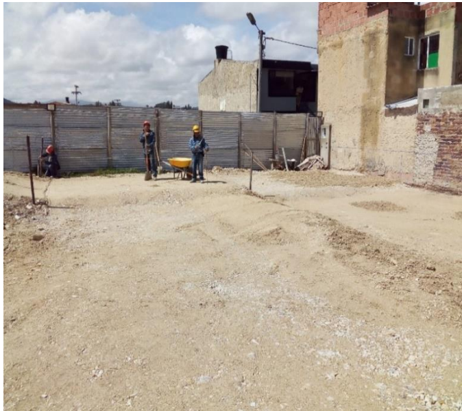
Ilustración 21. Niveles de terrazas terminadas.
