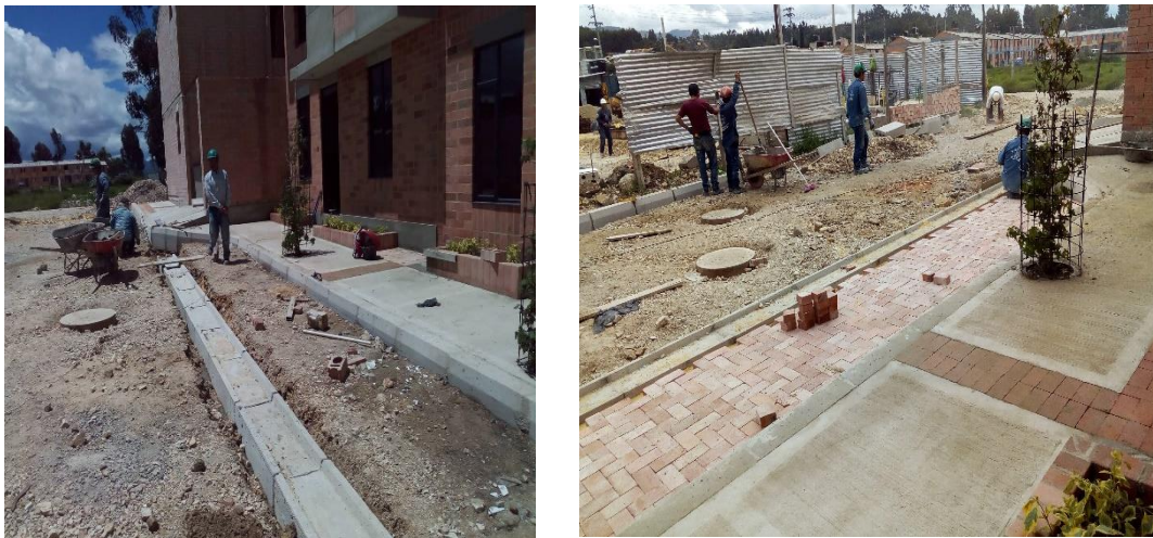
Ilustración 75. Acabado de andenes sobre la carrera 14.
