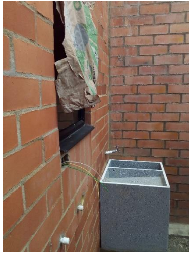
Ilustración 65. Instalación de lavaderos en patio de las viviendas.
