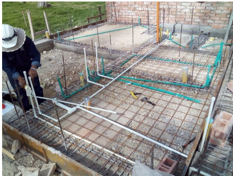
Ilustración 40. Instalación de redes hidrosanitaria y eléctrica viviendas del proyecto.
