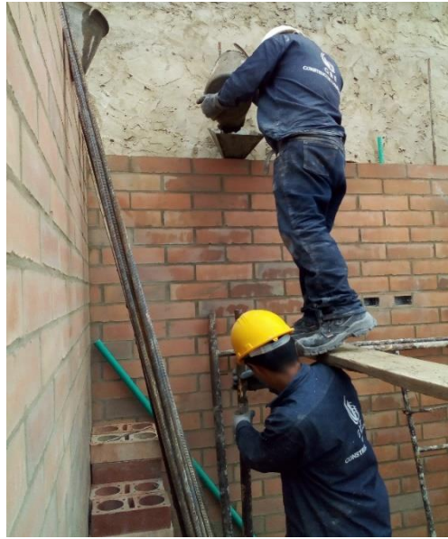
Ilustración 47. Fundida de dovelas.
