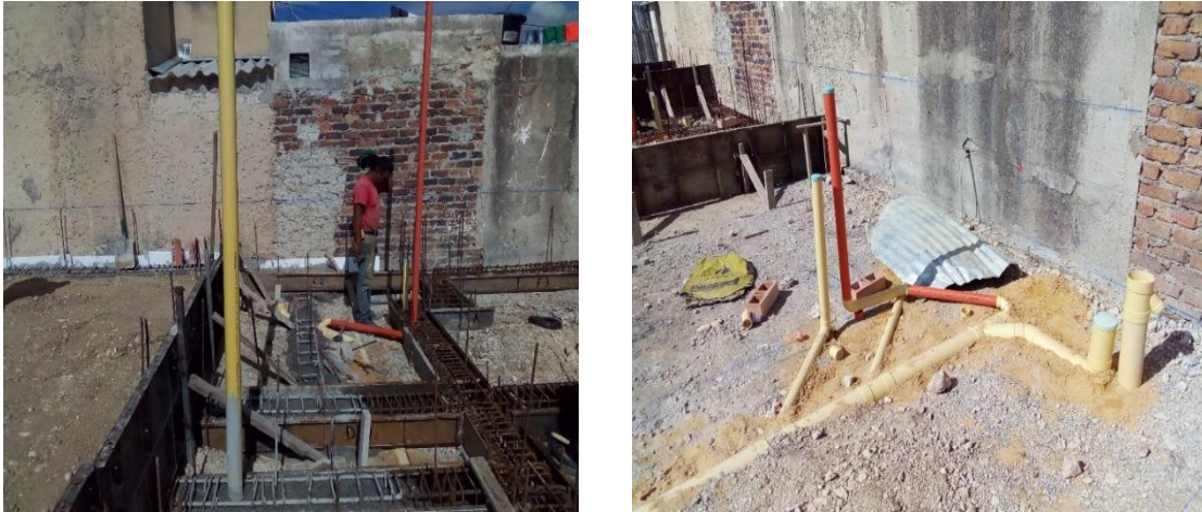
Ilustración 39. Instalación de redes hidrosanitaria en viviendas de la manzana 3A.
