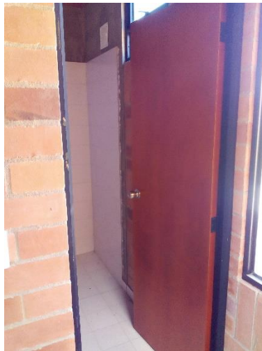
Ilustración 68. Instalación de carpintería de madera.
