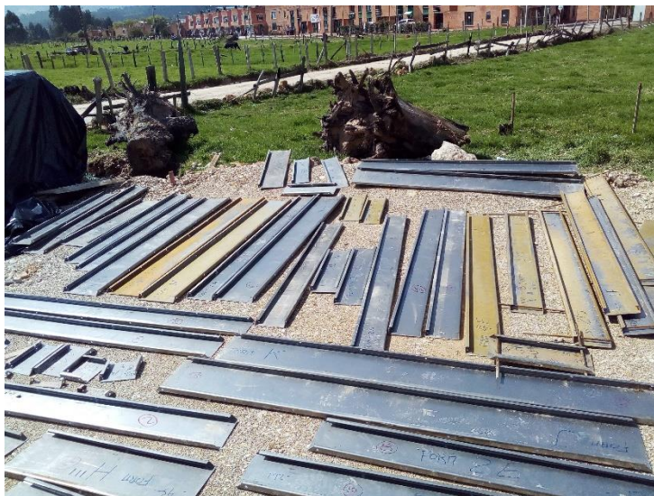
Ilustración 30. Formaleta metálica utilizada para las vigas de cimentación.
