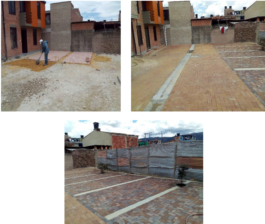
Ilustración 77. Adoquinamiento de andenes, vía y parqueaderos sobre la carrera 14A.
