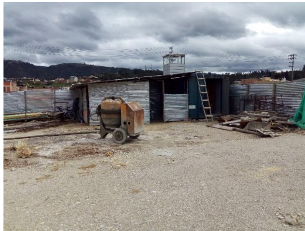
Ilustración 22. Campamento para contratistas.
