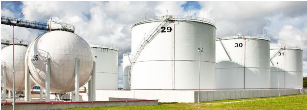
Ilustración 1 Tanques de Almacenamiento
