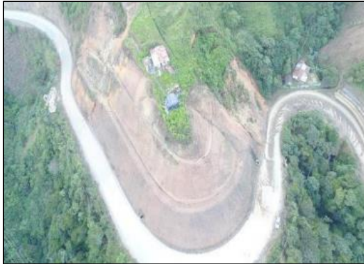
Figura 100. Talud antes de ser revegetalizado
