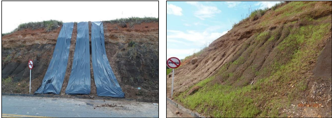
Figura 72. Proceso de Hidrosiembra manual
