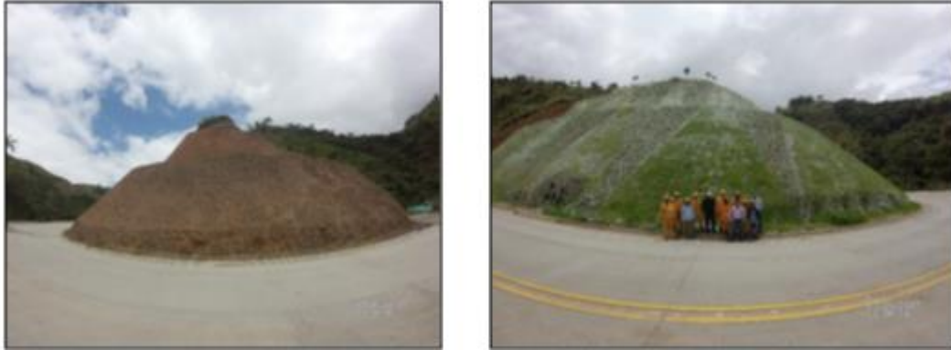
Figura 1022. Antes y después de revegetalizar el talud
