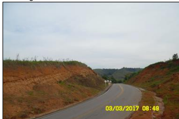
Figura 70. Talud antes de Revegetalización
