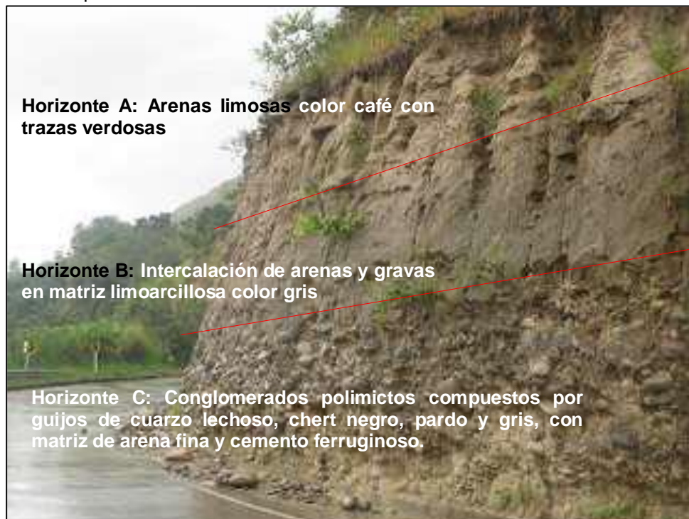
Figura 35. Descripción talud Plata – Puerto Valencia PR64+0000 Al PR65+250
