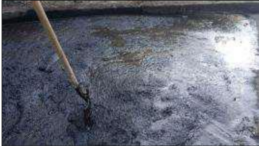
Figura 89. Preparación de la mezcla
