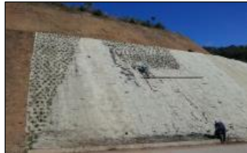
Figura 101. Preparación de la superficie e instalación del Biomanto
