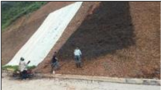
Figura 101. Preparación de la superficie e instalación del Biomanto
