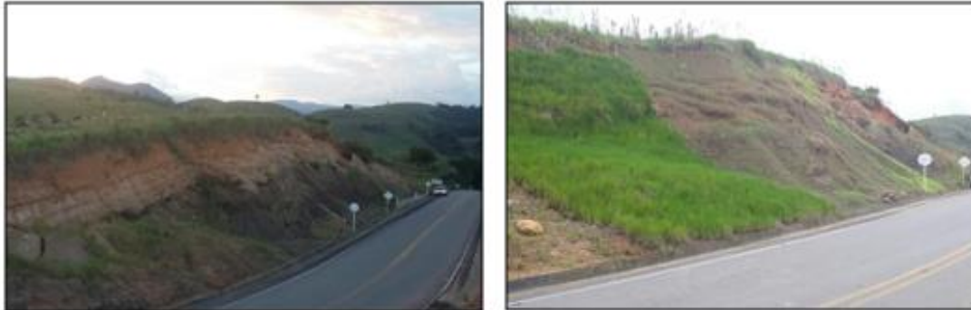
Figura 73. Antes y después de revegetalizar el talud
