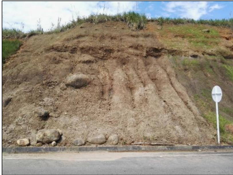
Figura 32. Panorámica del Talud San José del Fragua – Florencia, PR 04 +0000 al PR 4+0150
