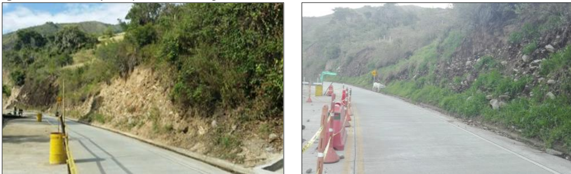
Figura 90. Antes y después de revegetalizar el talud
