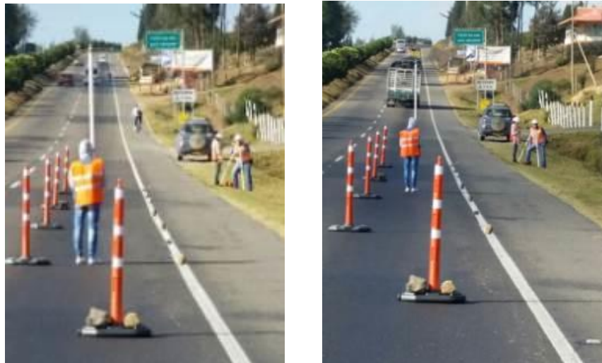
Figura 31. Medición de las cotas de perfil longitudinal del tramo con abscisas Km 119 800-860.
