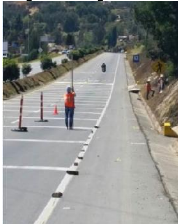
Figura 30. Medición de las cotas de perfil longitudinal del tramo con abscisas Km 116 760-820.
