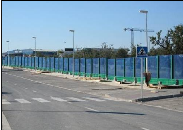
Figura 13. Barrera acústica para vías Fuente: Ingeniería Acústica (Domingo, 2013)
