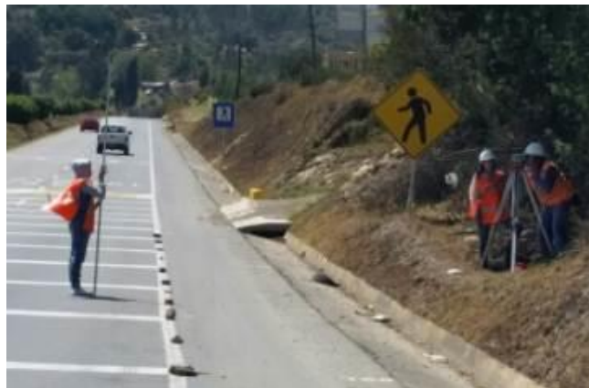
Figura 27. Posicionamiento de equipo de medición de índice de rugosidad, mira y nivel de precisión, abscisas Km 116 760-820. FUENTE: Propia
