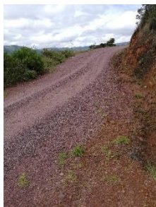
Figura 32:Cunetas en Tierra Abscisa K0+500.
