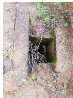
Figura 31:Alcantarilla en K1+950 -2.
