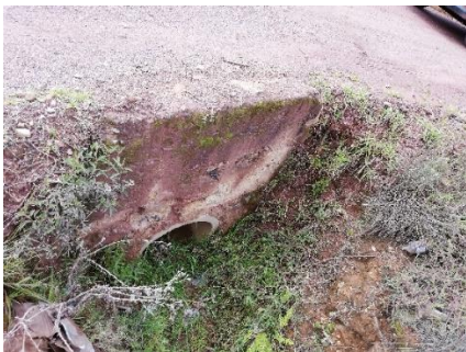
Figura 30:Alcantarilla en K1+950 -1.
