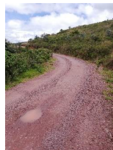
Figura 33:Cunetas en Tierra Abscisa K1+400.
