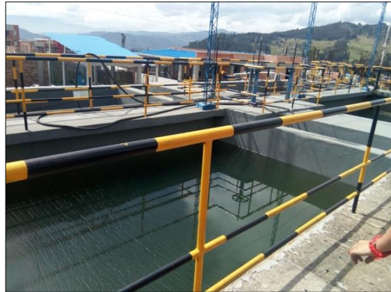
Imagen 13. Filtros de la planta de tratamiento
