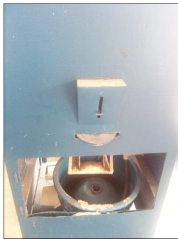
Imagen 6. Dosificador gravimétrico de sulfato de aluminio
