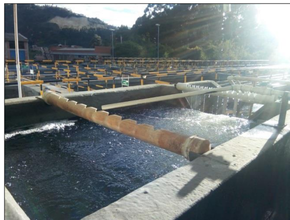
Imagen 7. Canaleta de dosificación de coagulante
