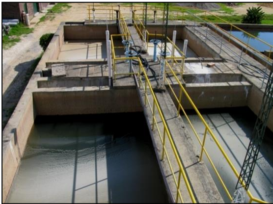
Imagen 13. Filtros de la planta de tratamiento
