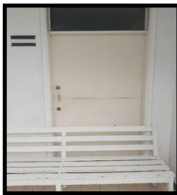
Fotografía 7. Puerta Deposito 2, Archivo Central Hospital Regional Sogamoso E.S.E.
