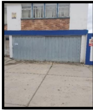
Fotografía 5. Puerta Deposito 1, Archivo Central, Hospital Regional Sogamoso E.S.E.
