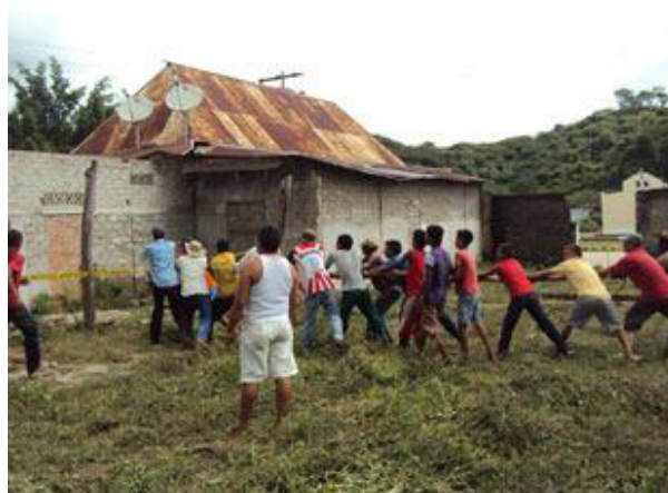
En convite la comunidad ayuda a demoler las edificaciones que había donde se construirá la Casa del Pueblo, cuyo diseño, donado por el arquitecto Simón Hosie, puede verse en la foto de abajo.
