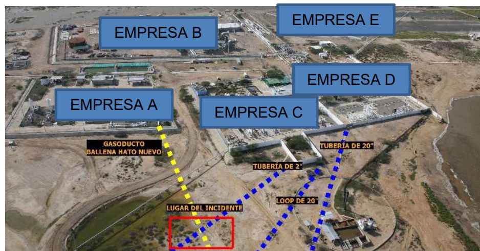
Fotografía 1 Localización de tuberías y lugar del evento
