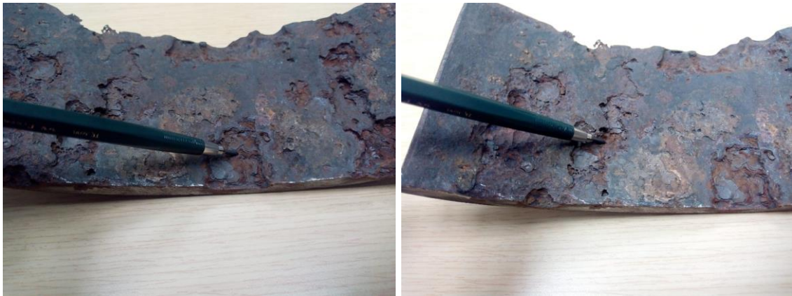
Ilustración 20. Mecanismos de daño combinado en línea troncal
