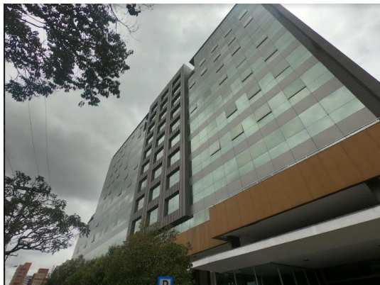
Ilustración 3. Edificio entrada principal de la ANLA
