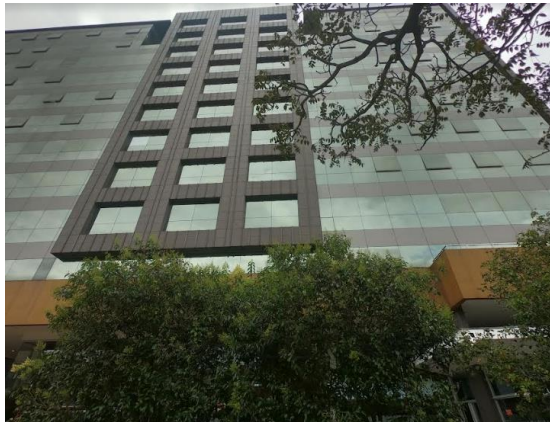
Ilustración 2. Edificio entrada principal de la ANLA
