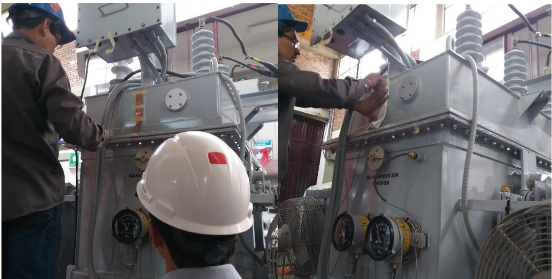
Figura 28 Instalación de los Termopares para el ensayo
