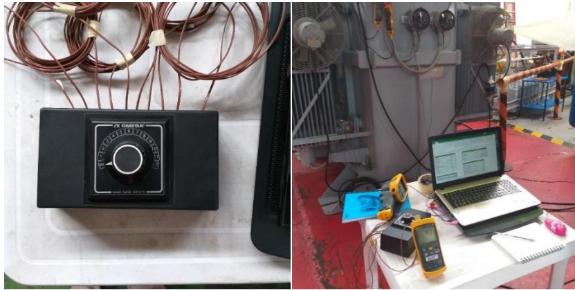
Figura 4 Termómetro, termopares y conmutador selector giratorio
