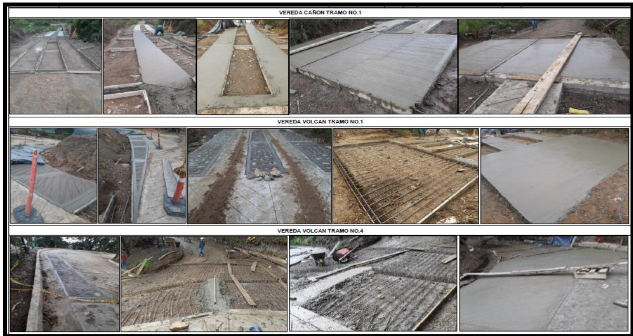
Figura 13. Ejecución y construcción de las placas huellas Contrato No. 7
