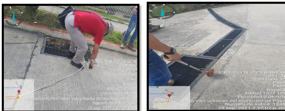
Figura 6. Registro fotográfico de la rehabilitación y el mejoramiento de la carrera 3B costado oriental entre calles 2 y 3 y rampa de aproximación vía entrada sede secundaria IE JAP parte 2.
