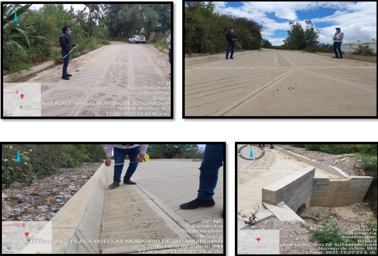
Figura 9. Ejecución de placa huella municipio de Sutamarchan
