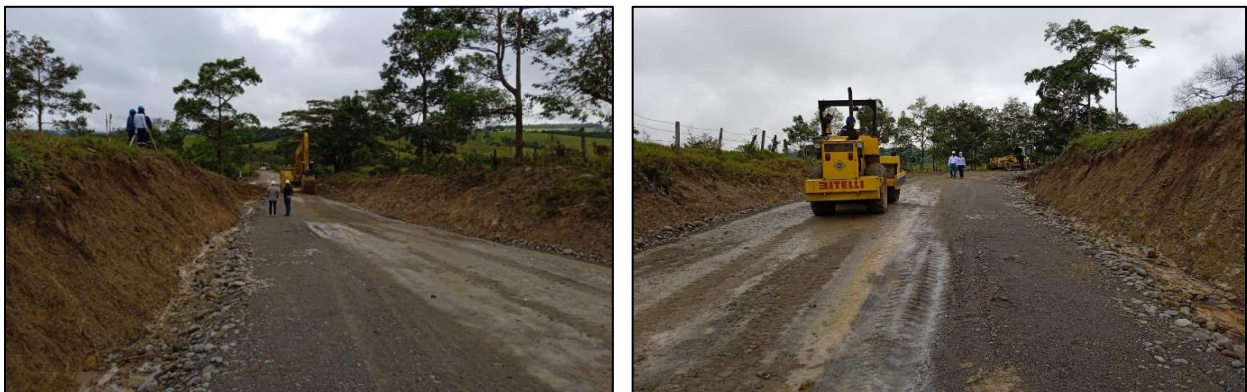
Figura 19. Recorrido a actividades de mejoramiento PR 00+0700 al PR 03+700
