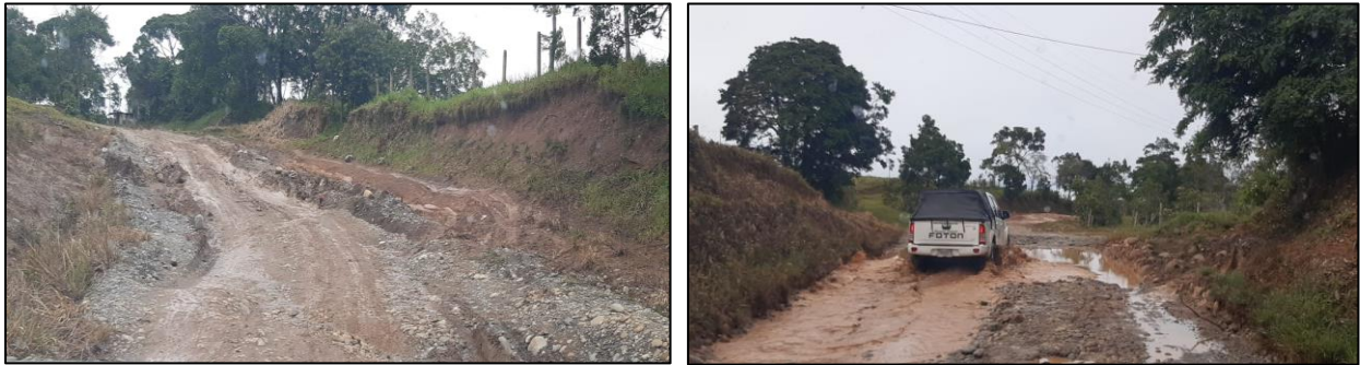
Figura 16. Recorrido de Jardín de las Peñas a la Uribe PR 25+000 a PR 00+000
