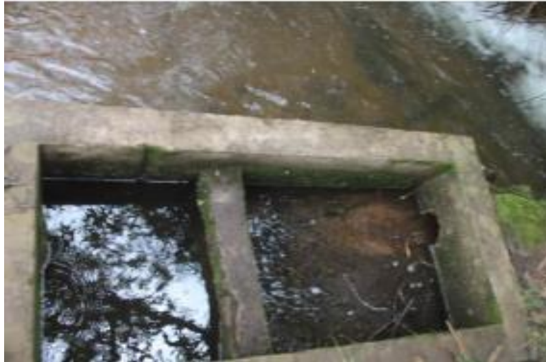
Desarenador Acueducto Vereda Santana
