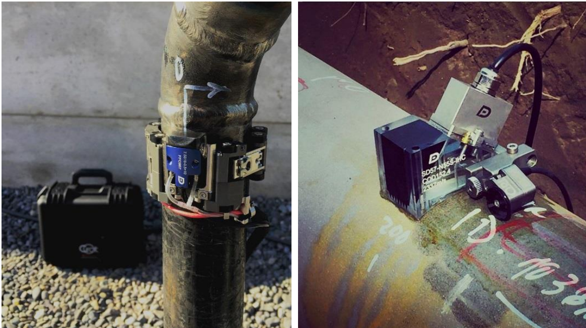
Ilustración 13. Sistema de inspección ROV tipo Crawler aplicado a tuberías.
