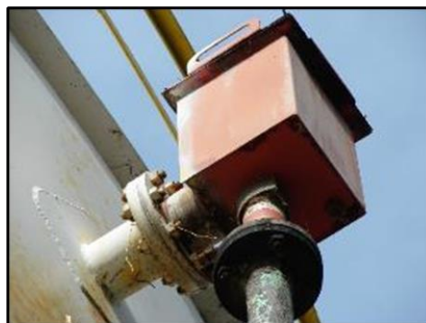
Figura 13. Tk Bolívar. Tuberías y conexiones.
