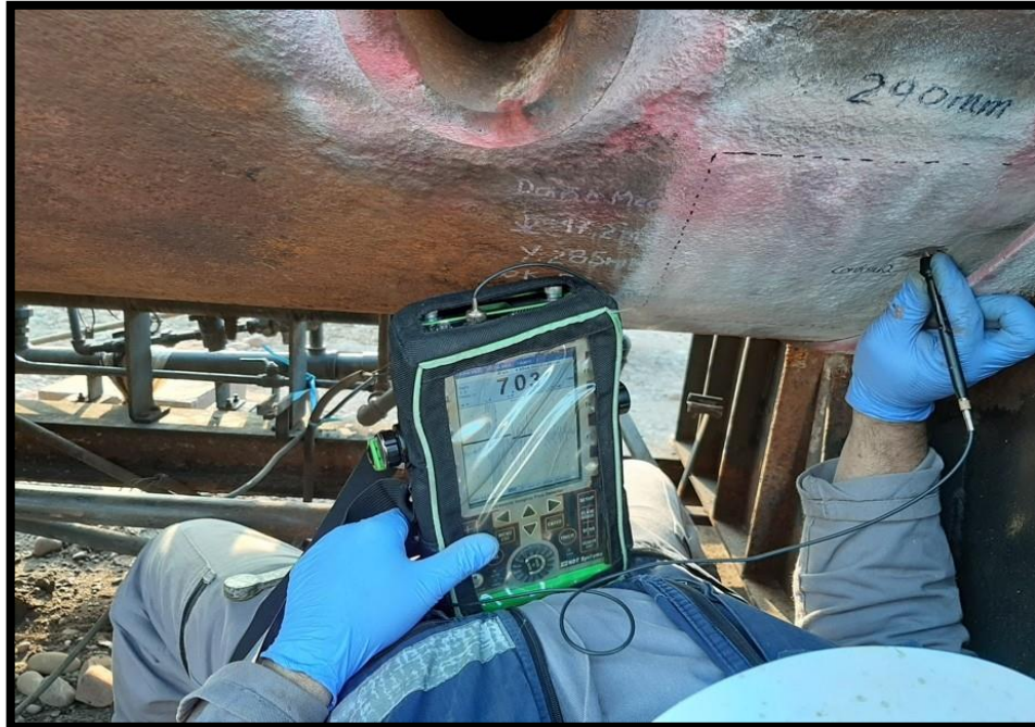
Ilustración 15. Medición de espesor UT Scan A con palpador tipo lápiz en daño mecánico
