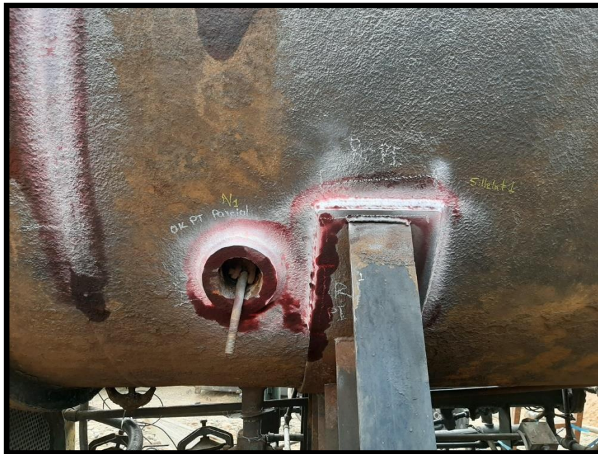
Ilustración 9. Pruebas de PT realizadas a soldaduras del cuerpo de la caldera de vapor
