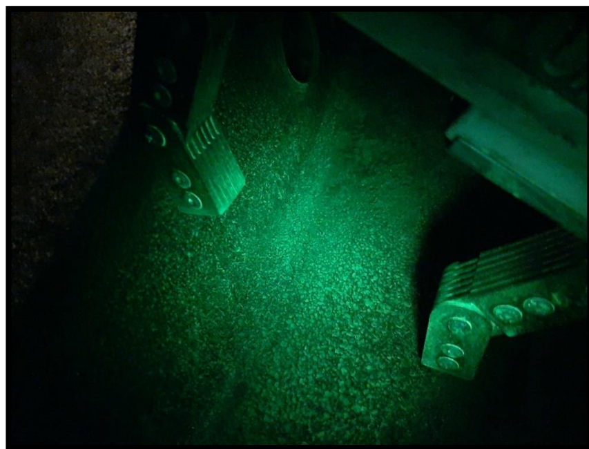
Ilustración 12. Pruebas de MT fluorescentes en soldadura a filete entre batea y extremo tubo hogar
