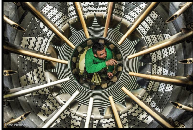
Ilustración 3. Inspección visual, la técnica más versátil entre los END
