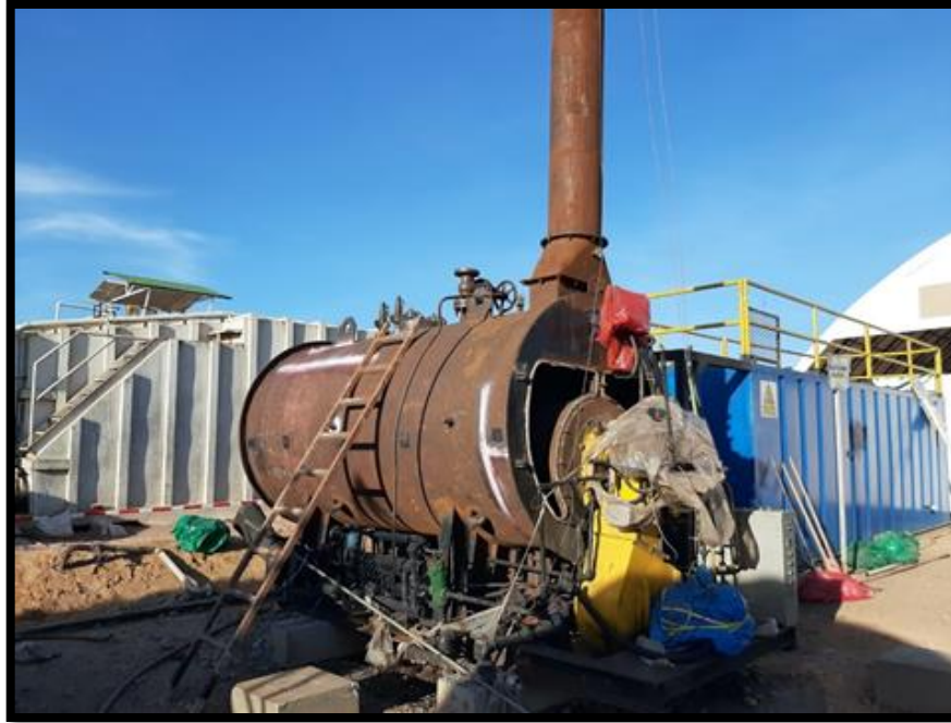
Ilustración 6. Caldera de vapor pirotubular PEI El Alcaraván
