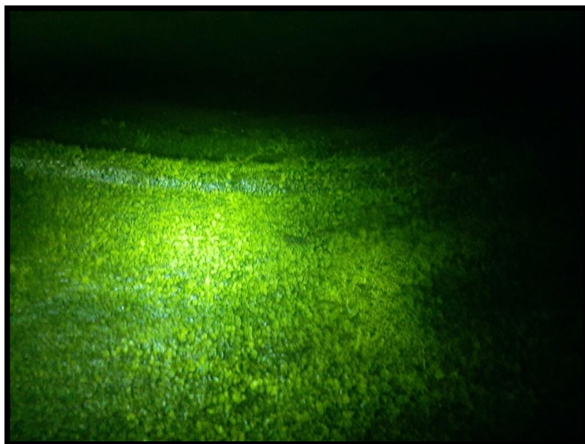
Ilustración 11. Pruebas de MT fluorescentes en parte inferior extremo del tubo hogar.
