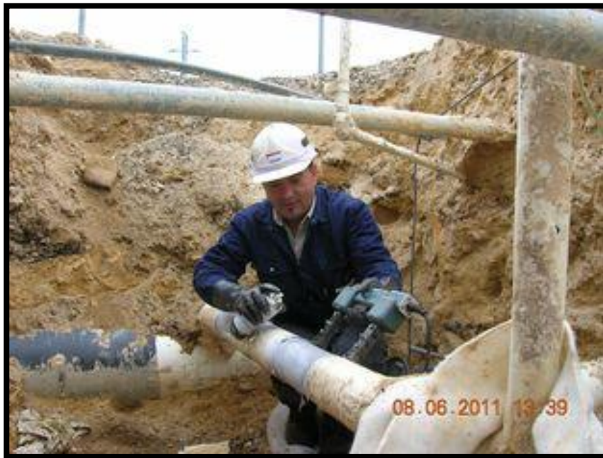
Ilustración 5. Inspección por partículas magnéticas.
