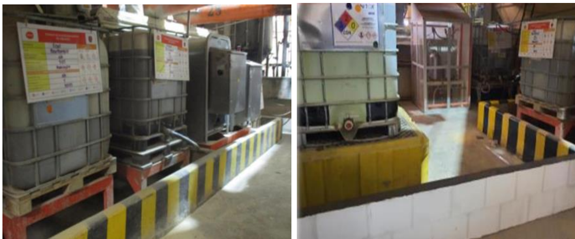
Figura 31. Diques de contención dosificación
