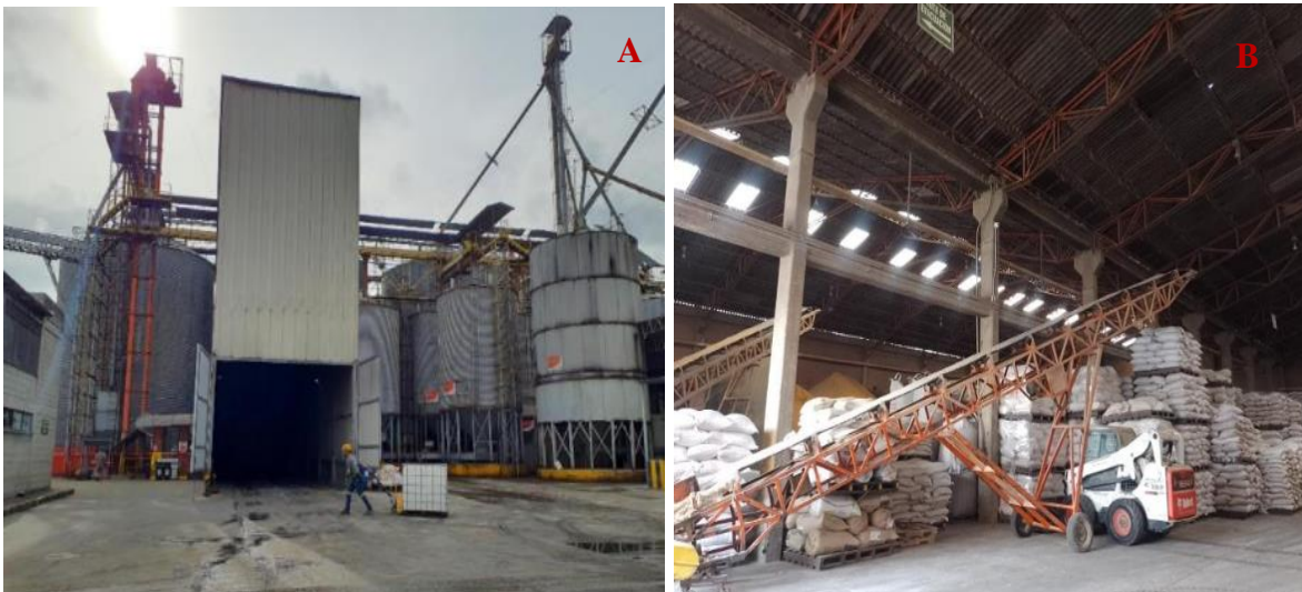
Figura 5. Área de recibo y almacenamiento de materias primas
