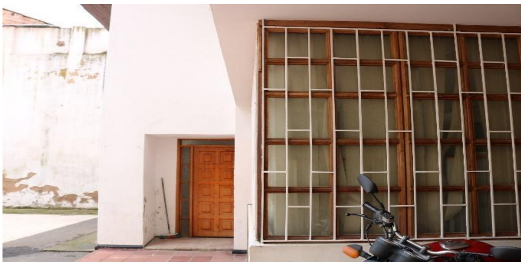
Fotografía 5. Salón anexo, primer piso, casa amarilla.
