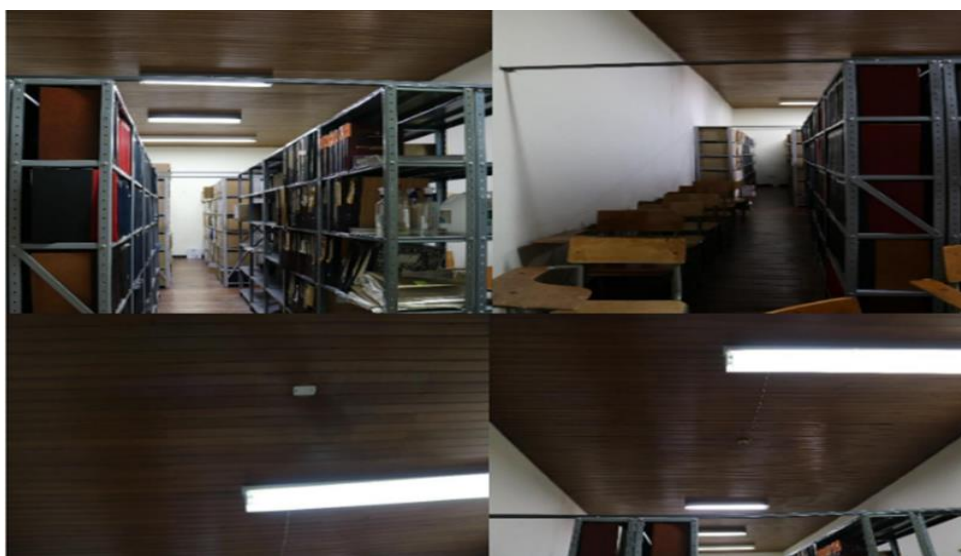
Fotografía 18. Tubos de luz artificial, depósito de archivo.
