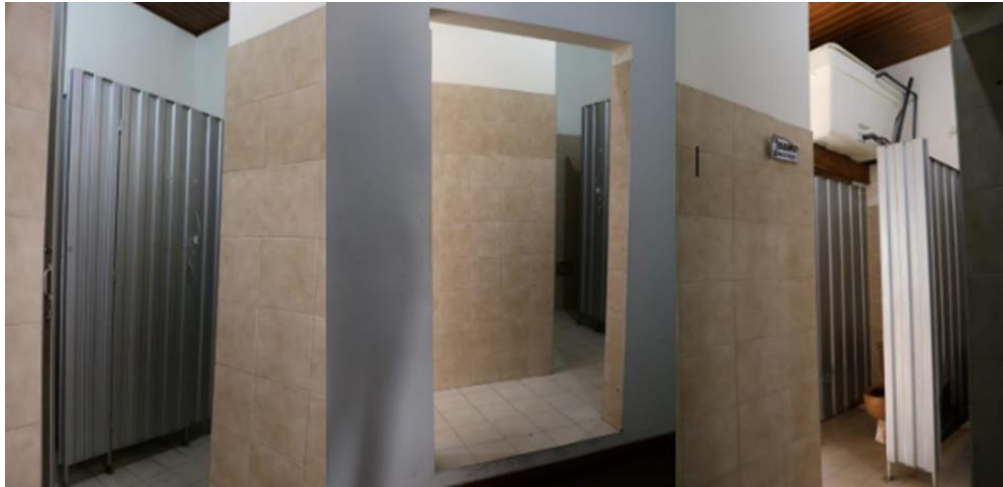
Fotografía 7. Baños de la casa amarilla, tercer piso.
