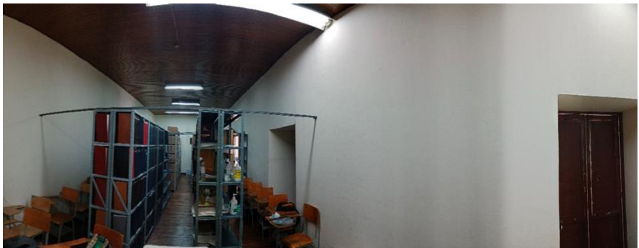
Fotografía 24. Paredes del depósito de archivo.
