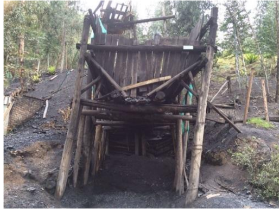
Imagen 2. Tolva de almacenamiento.
