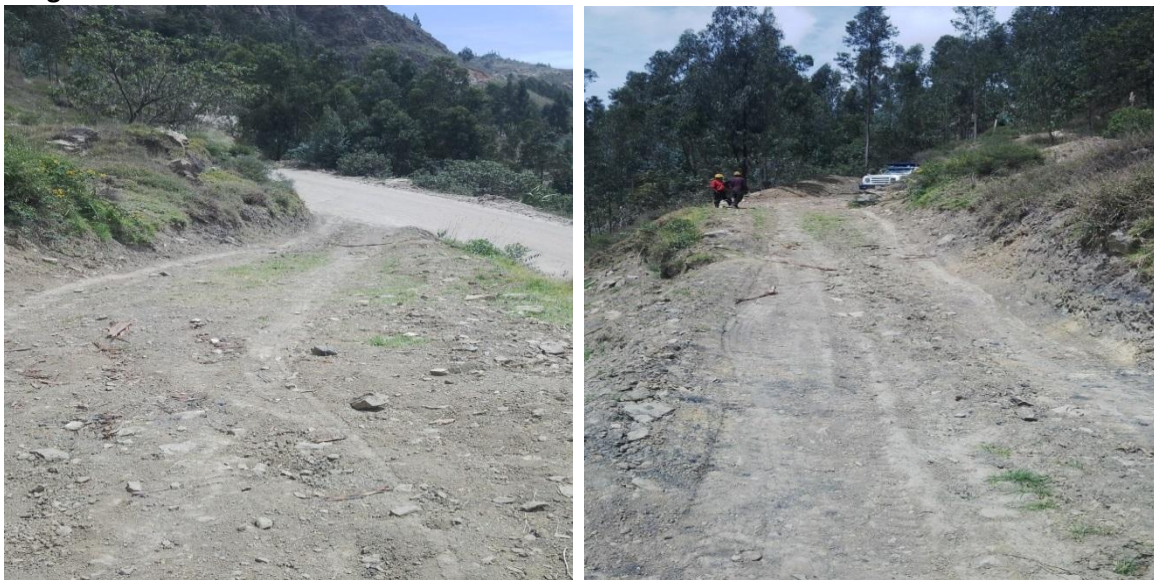
Imagen 4. Vías de acceso a la bocamina.
