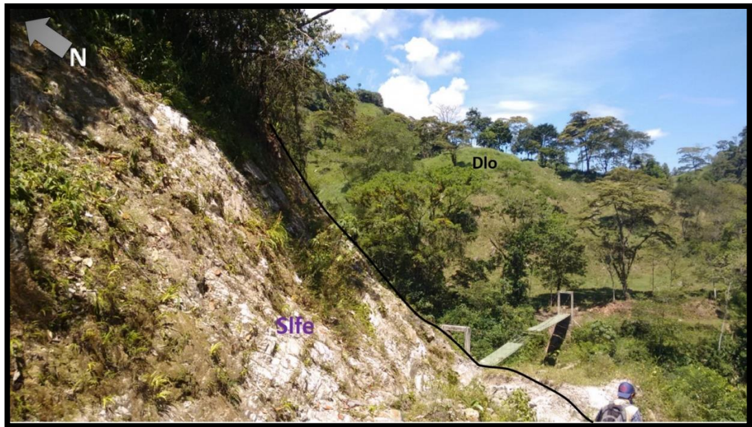
Figura 10: Proyección de la geoforma de Ladera Ondulada (Dlo) en el margen oriental de la Quebrada Agua Fría (Coordenadas: E: 1'099.127; N: 1'027.960; Proyección: 55°)
