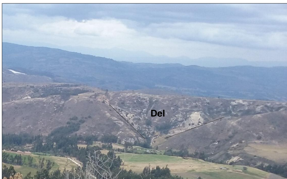
Fotografía 14. Ladera Erosiva Vereda Caracoles.
