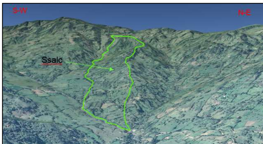
Figura 51. Ladera de Contrapendiente de Sierra Anticlinal.
