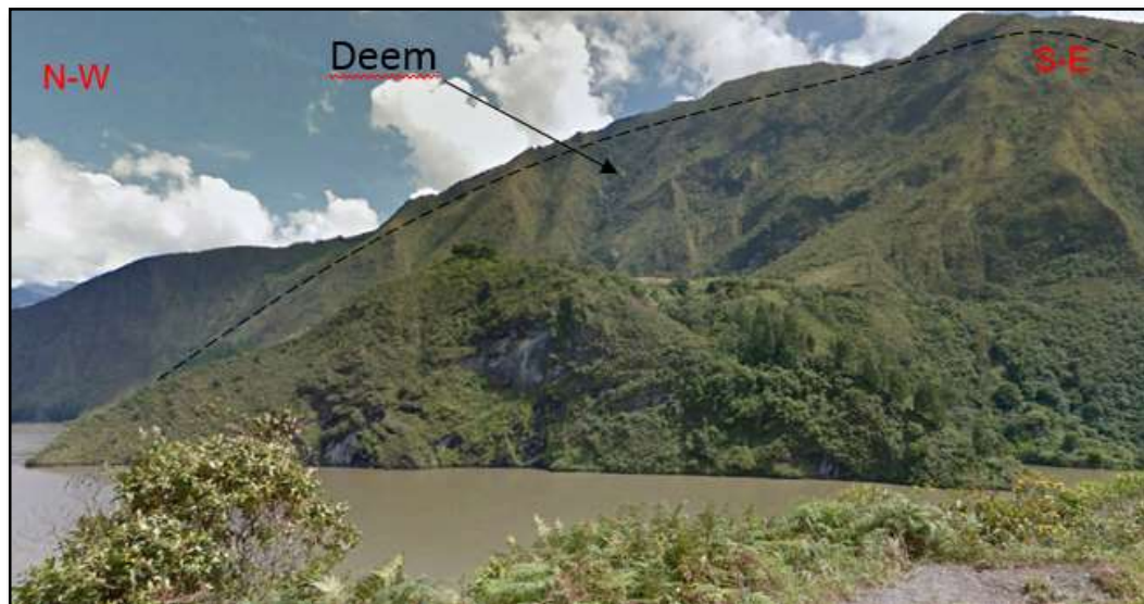
Fotografía 13. Escarpe de Erosión Mayor.
